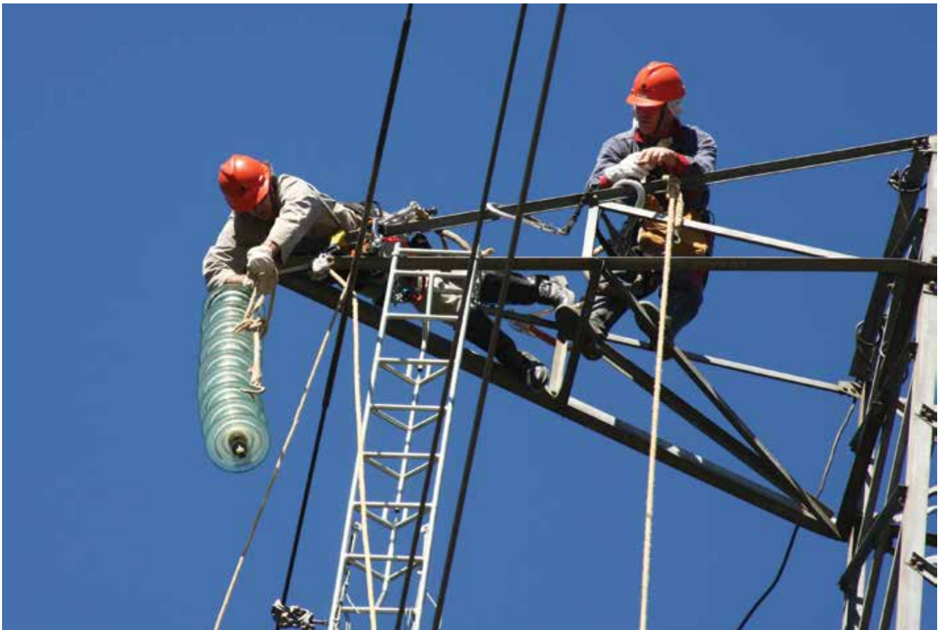
Manutenção de linha de transmissão da Eletrosul, subsidiária da Eletrobras
