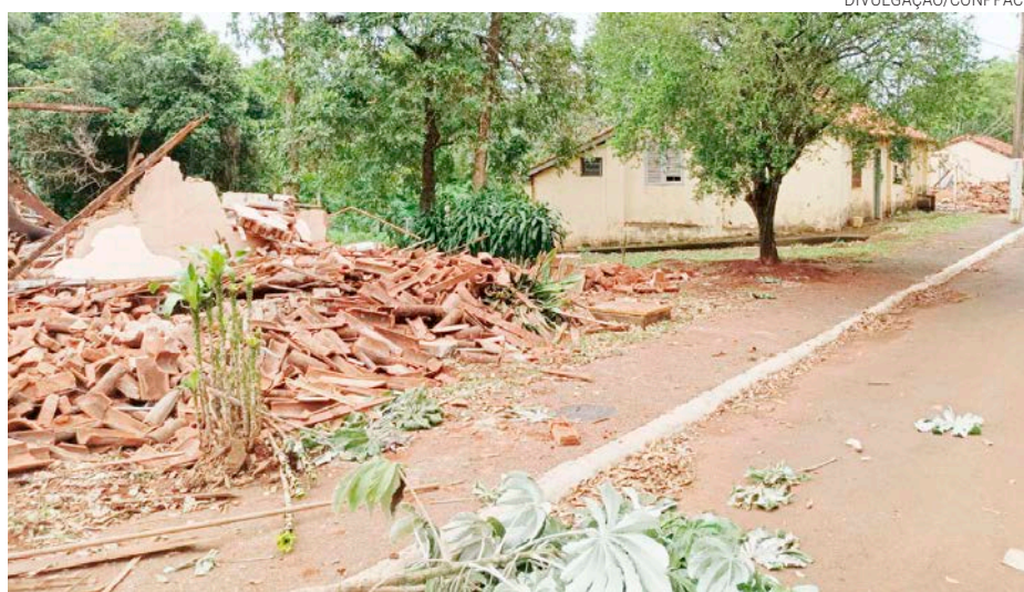
Conppac barrou nesta terça-feira a destruição de casas das colônias Milanese e Napolitana, na USP, mas três unidades foram demolidas
