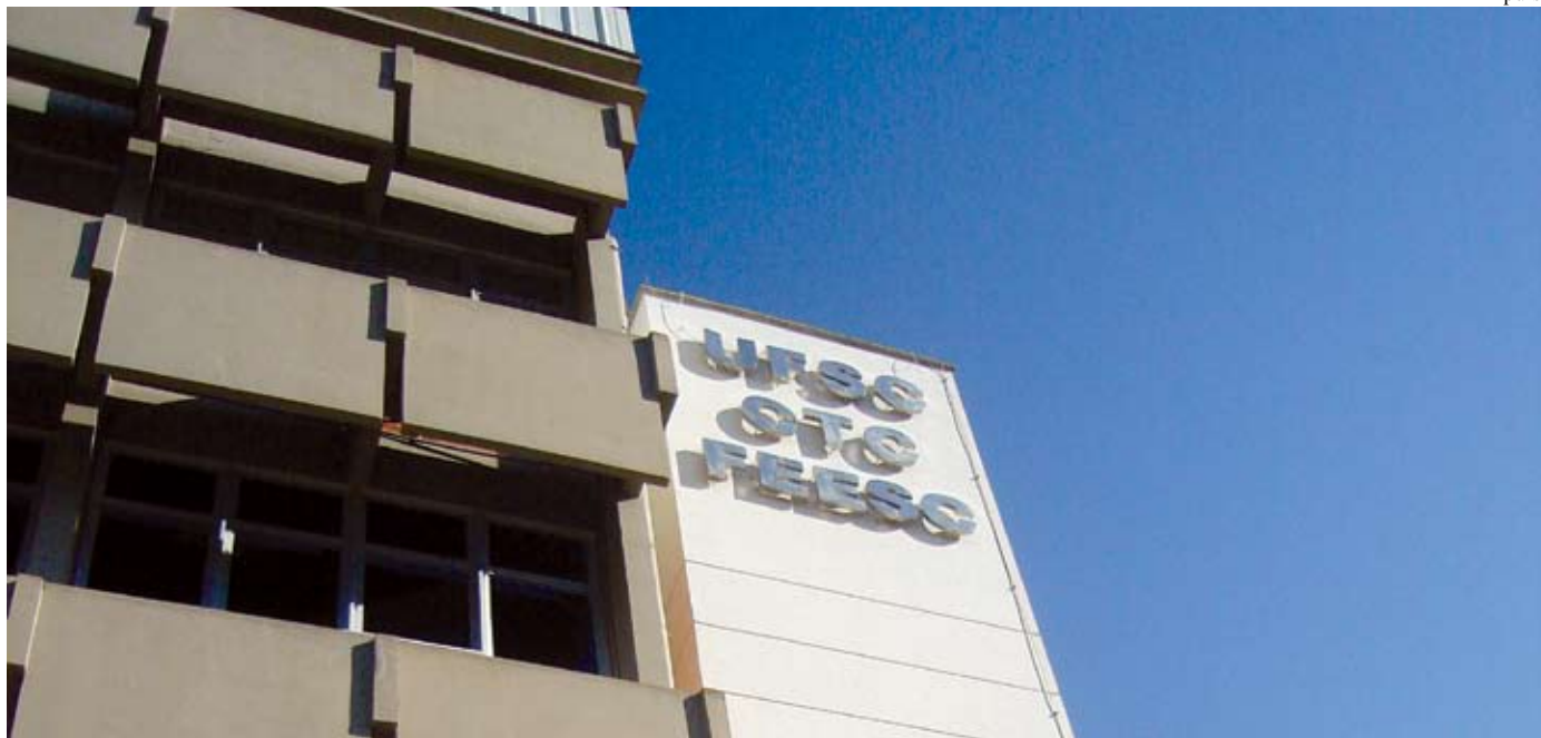
Siglas na fachada do prédio do Centro Tecnológico sinalizam confusão de papéis e conflito de interesses
